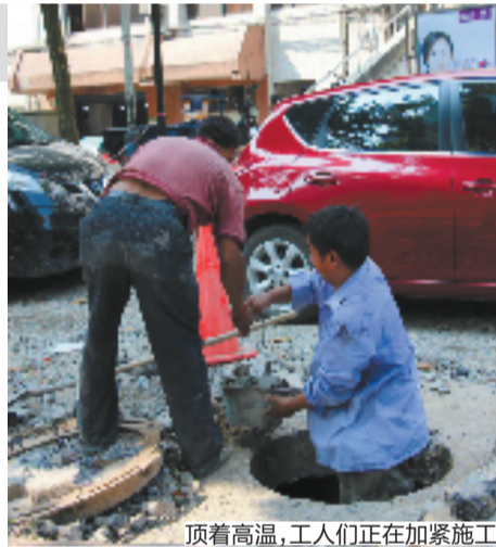
顶着高温, 工人们正在加紧施工
