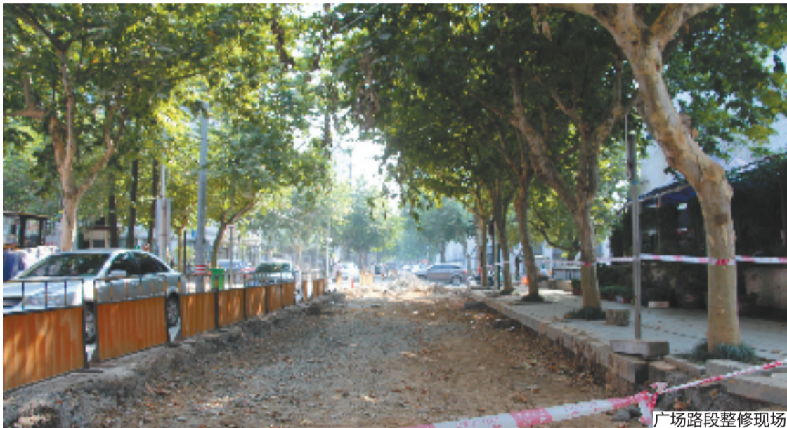
广场路段整修现场
