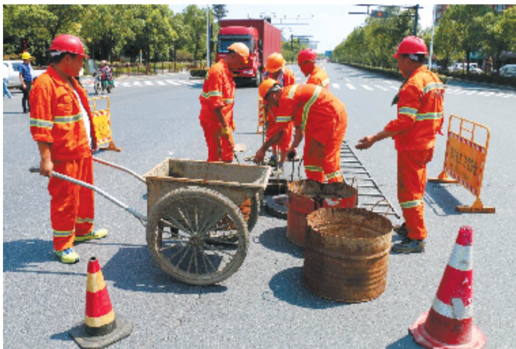
修复损坏井盖
