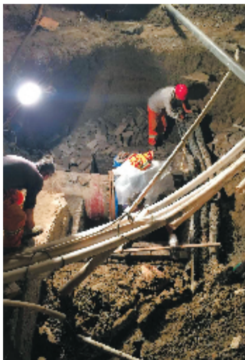
实施泵站水管工程
