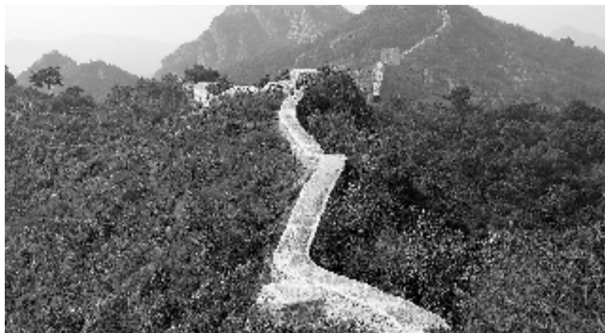
9月23日拍摄的锥子山长城大毛山段修缮后的容貌
