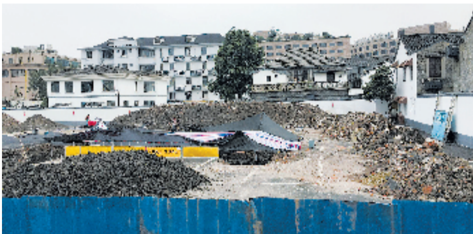
图为劝业里已完成拆迁的地块。 江嘉宜 摄
