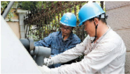
萧山电力抢修人员快速开展故障排查 徐国锋/摄
