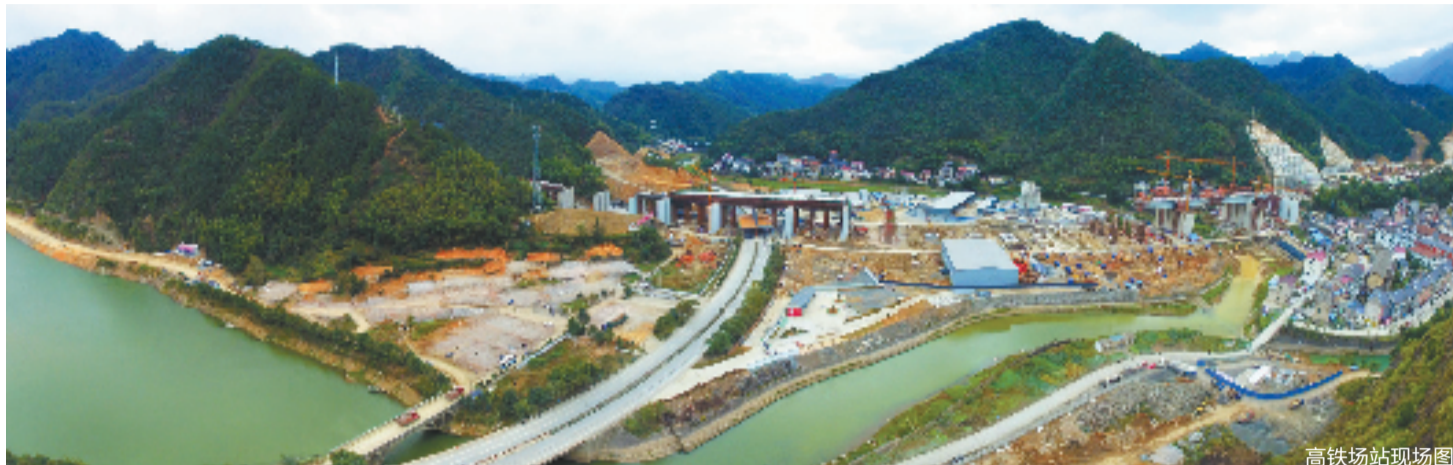
高铁场站现场图
