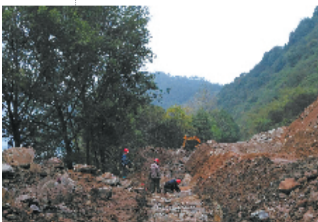
白章线边坡整治中
