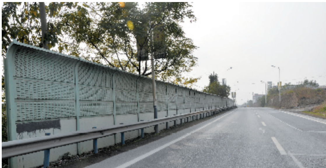
330国道大慈岩中心小学段安装隔音屏
