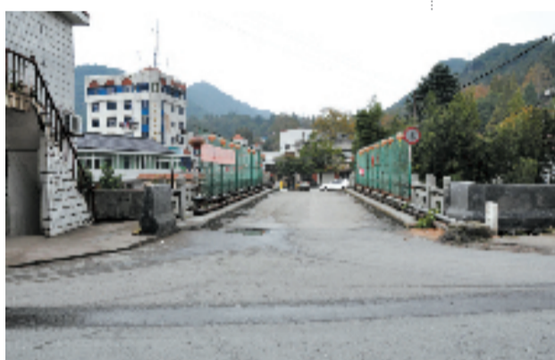
白小线岭后桥整治后
