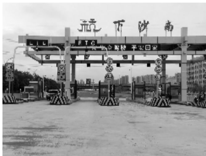
下沙南互通工程
