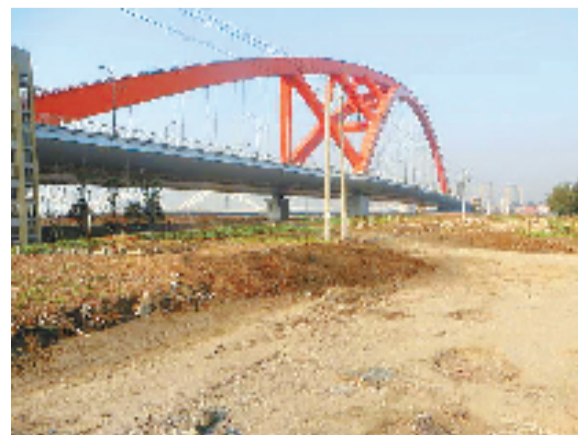
运河二通道桥下整治前后。
