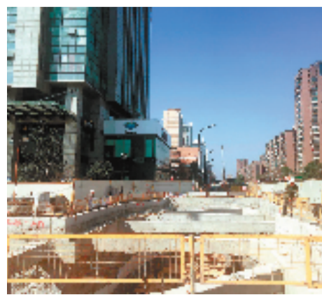
5号线平海路站施工处
