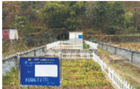
五星村英石下自然村污水处理设施
