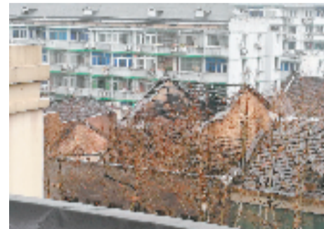
起火建筑为砖木结构, 楼顶已烧穿。
