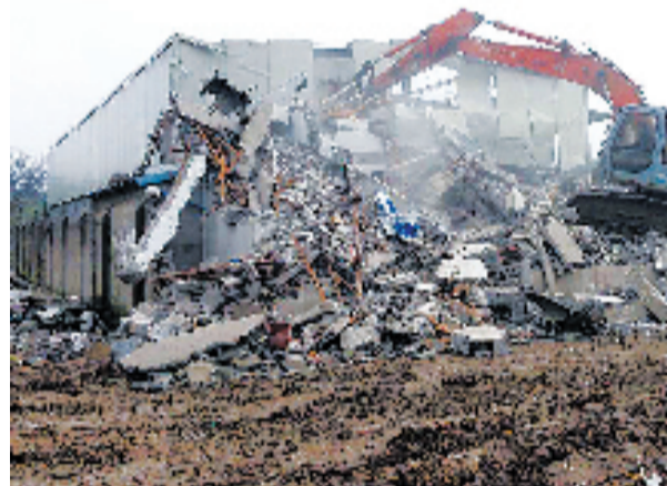
聚首路东侧违建拆除
