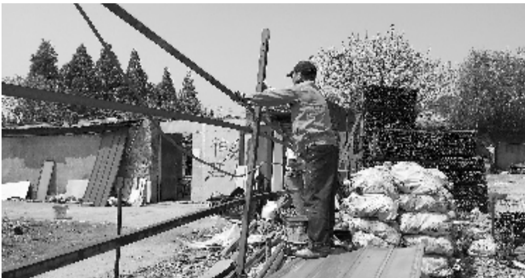
工人正在拆除围挡。
