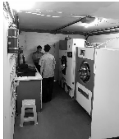
私建洗衣房现场
