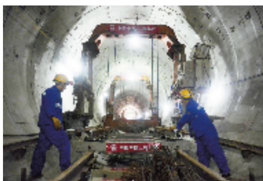
地铁1号线下沙延伸段轨通。 摄于2015年5月
