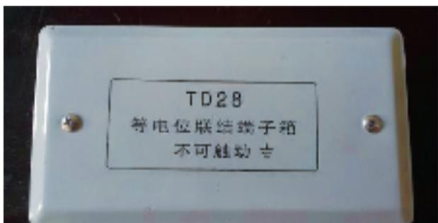
在日常起居中,有一个能够保障你生命安全的装置叫等电位,它是安装在卫生间一个不起眼的墙面上,很多人都不知道这个装置起到什么作用。作为与漏电保护器同等重要的家用防触电装置,“等电位”装置事关人的生命,应当引起大家的充分重视。
