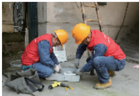
供电人员更换破旧表箱
