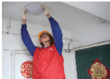
供电人员为城中小区安装楼道灯 百姓回家的路。
