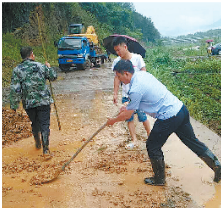
黄垅村在挖掘机与人工协作下道路恢复通车
