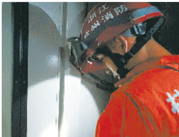
消防官兵正在破拆电梯门
