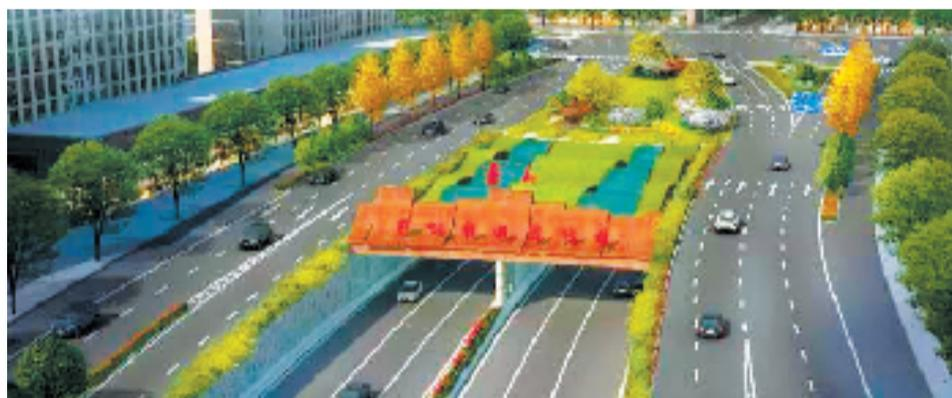
项目主线设计时速80公里/小时,采用双向六车道,标准段宽25米,主线隧道暗埋段结构宽29.1米。
