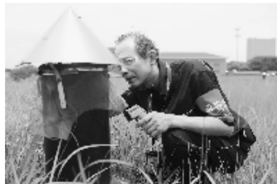
机房巡检完毕,沈荣到室外蓄水池检查水池的透气口有无阻塞。
