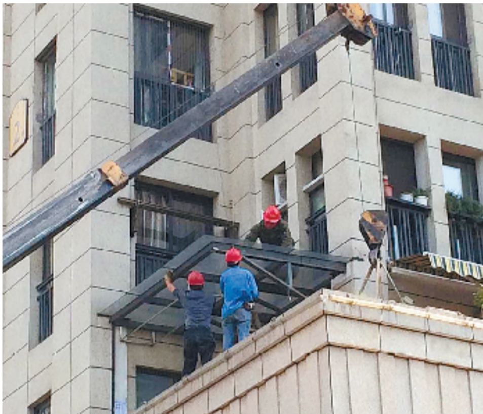
图为违建拆除现场。
