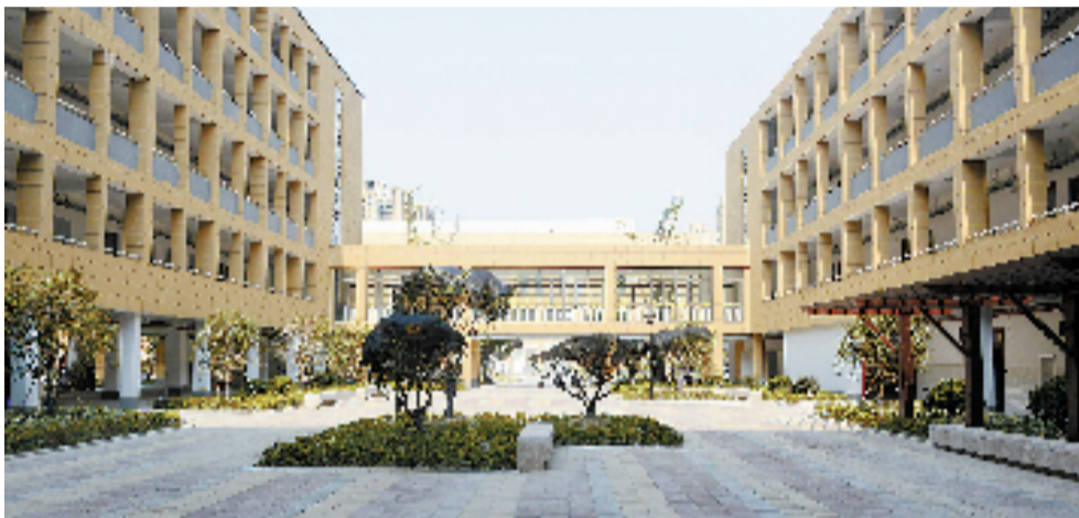
学校主体已经完工。
