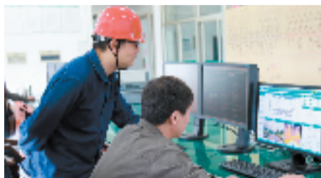
萧山区供电公司工作人员 设置智能巡检机器人巡检线路 李俊摄
