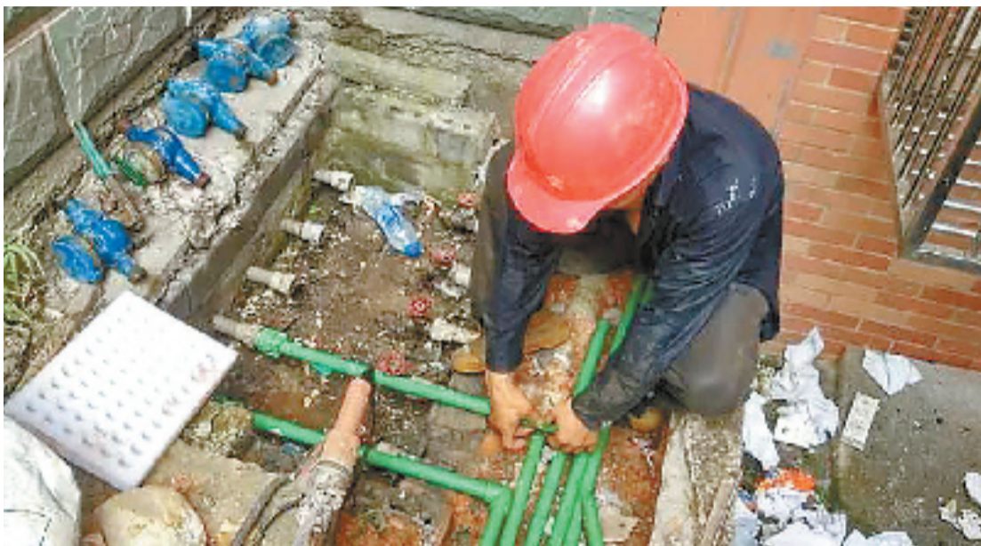
工人正在改造作业中
