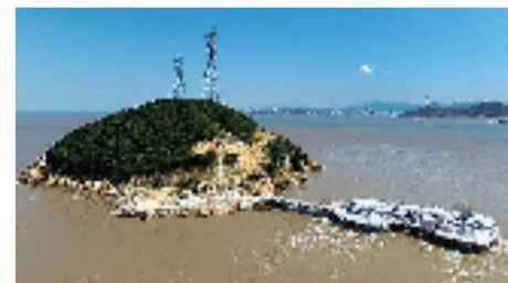
秀山岛海洋能发电机组项目。
