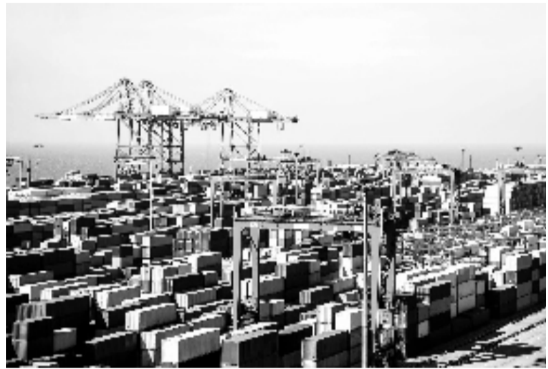
洋山深水港集装箱码头起重吊塔群
