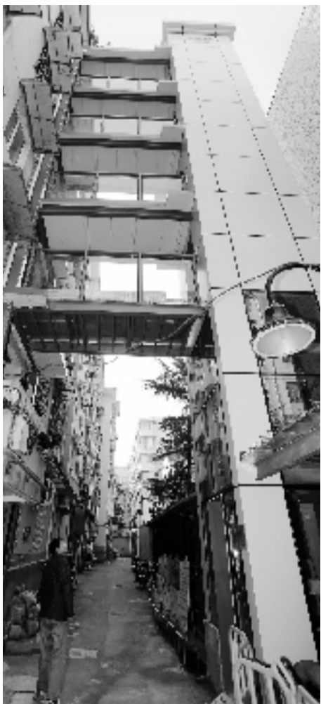
新民村2幢1单元用连廊连接居民楼和电梯。
