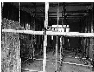
由钢管和夹板构成的保护措施延伸到房间内部。
