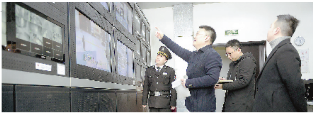
房管局工作人员检查物业消控室
