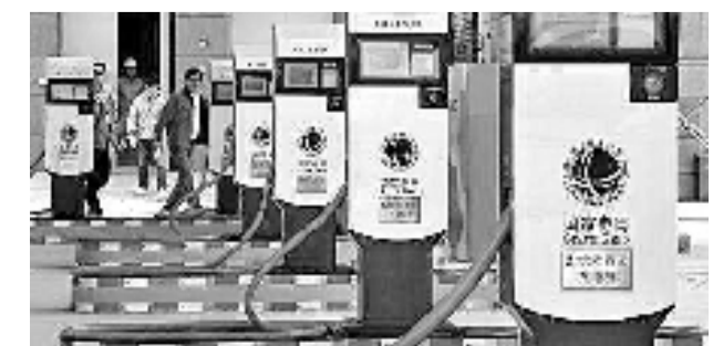
近期在服务区、收费管理站建设充电桩,为电动车提供充电服务。
