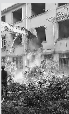
凯旋路258号2幢拆除现场
