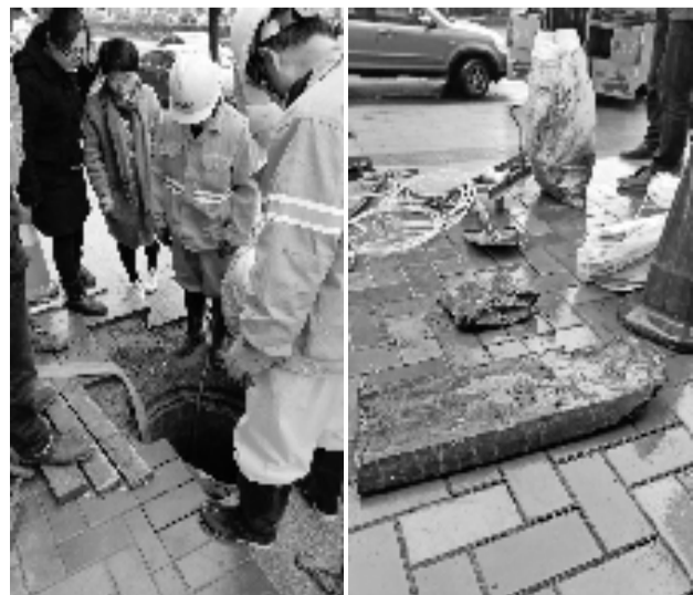
工人们在疏通污水预留井。 污水管网中取出的水泥块。
