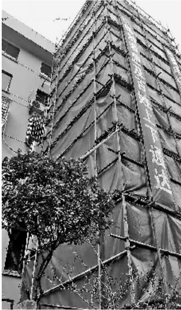
华家池34幢加装电梯已经完成了基坑工作,正在进行钢结构井道拼接。
