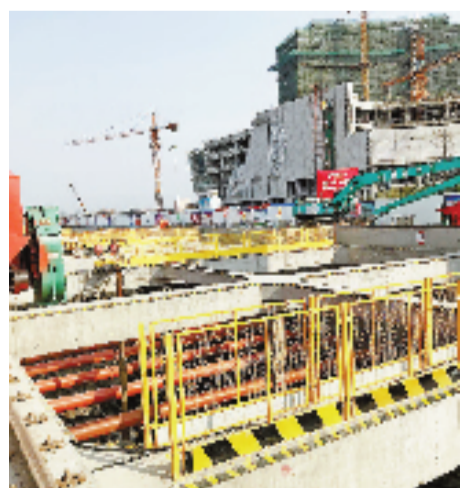
杭海城际铁路的车站结构渐渐成型。
