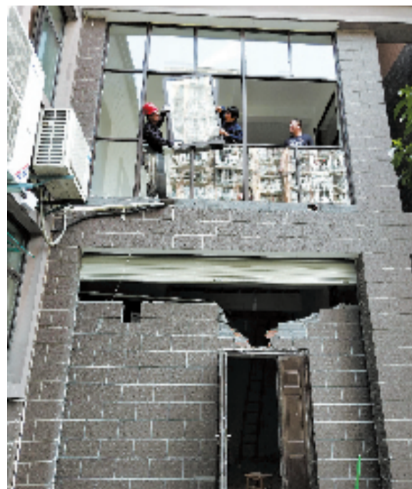
工人正在拆除架空层违建
