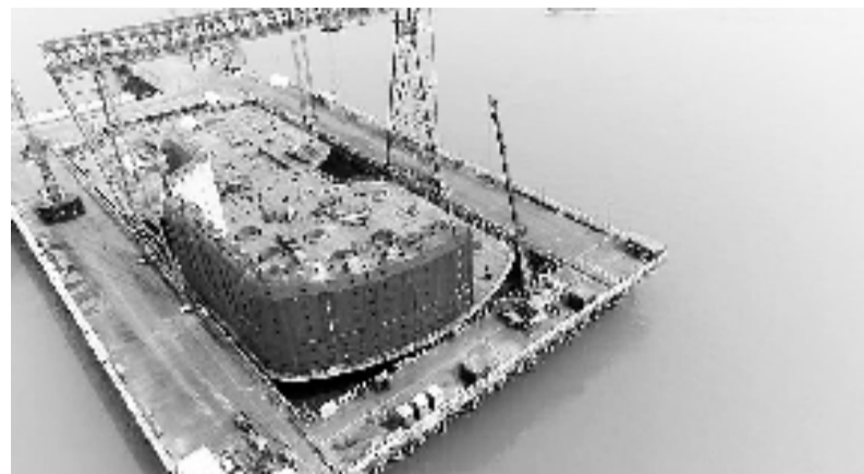
北口大桥施工现场。
