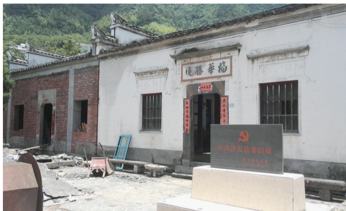
综合保护项目施工中的县委旧址
