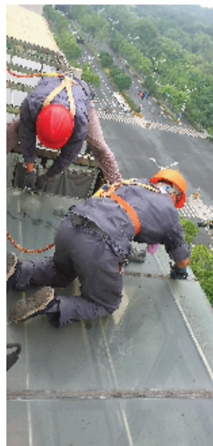
工人正在拆除违建
