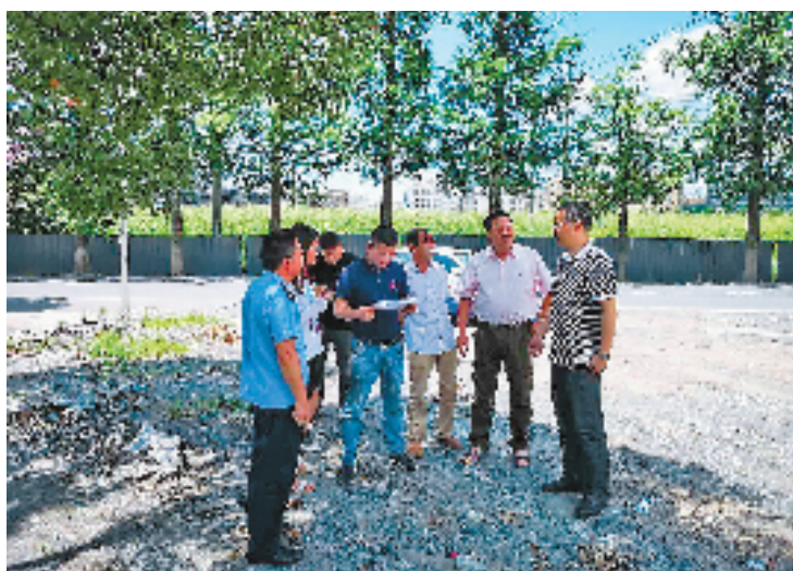
◀图为余杭街道开展“低小散差”整治现场。
