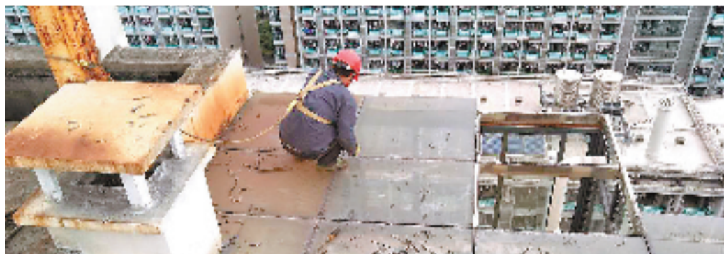
施工队正在拆除阳光房。
