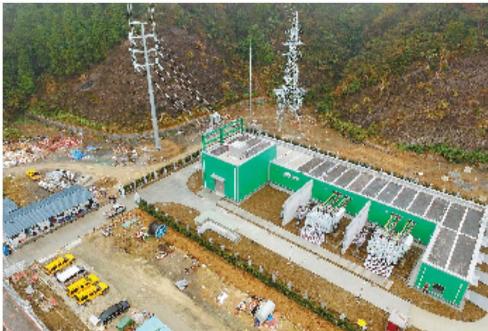
110千伏文昌变电站位于淳安县高铁新区浪苑口隧道北侧,总用地5.77亩,总建筑面积879平方米。本期新建40兆伏安主变压器两台,110千伏出线2回,35千伏出线4回,10千伏出线16回,新建双回路架空线路14.737千米。
