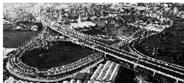
杜桥互通已通车。
