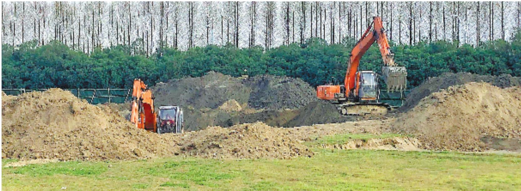
大草坪上,正在进行景观提升施工。
