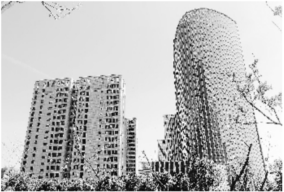
巨化项目已竣工
