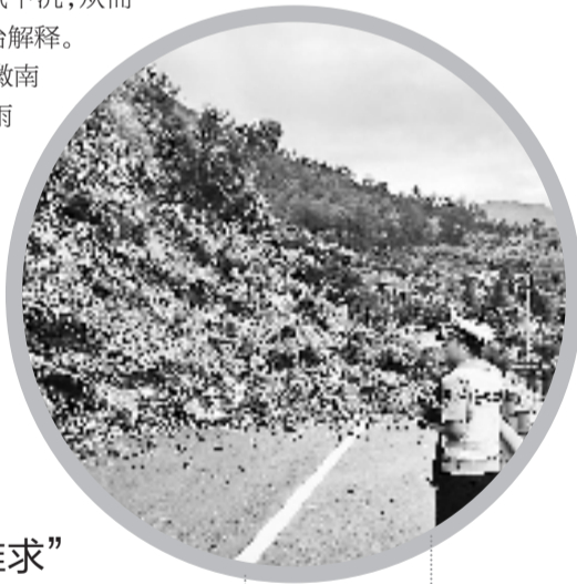
接连暴雨,台州临海国道发生山体持续性塌方。
