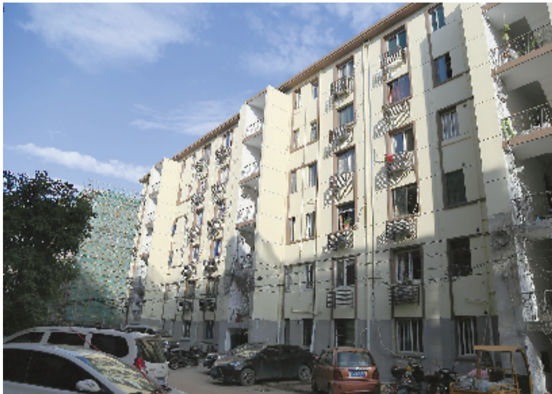
改造后的4号楼
