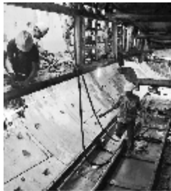
正在掘进的作业面,就是魏文杰和同事们战斗的地方。
