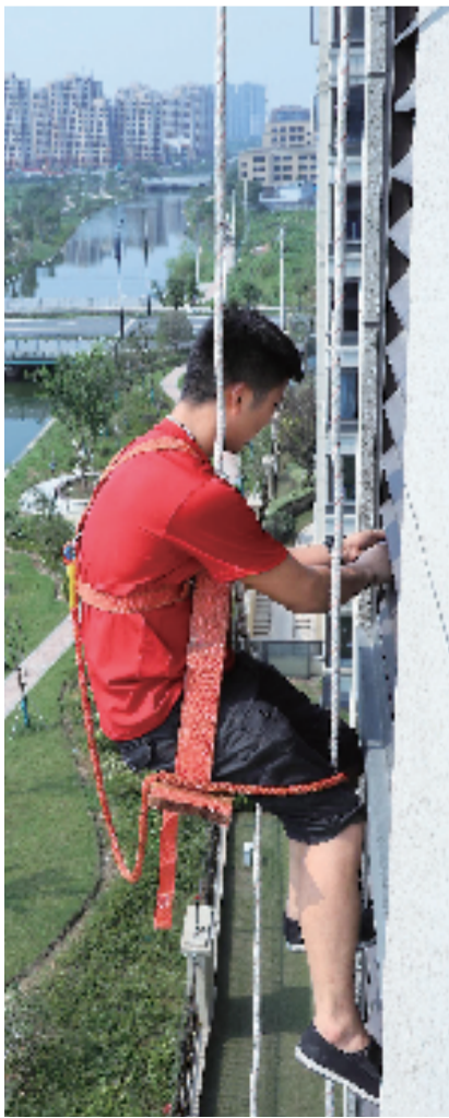
倪师傅在窗外安装小米空调
